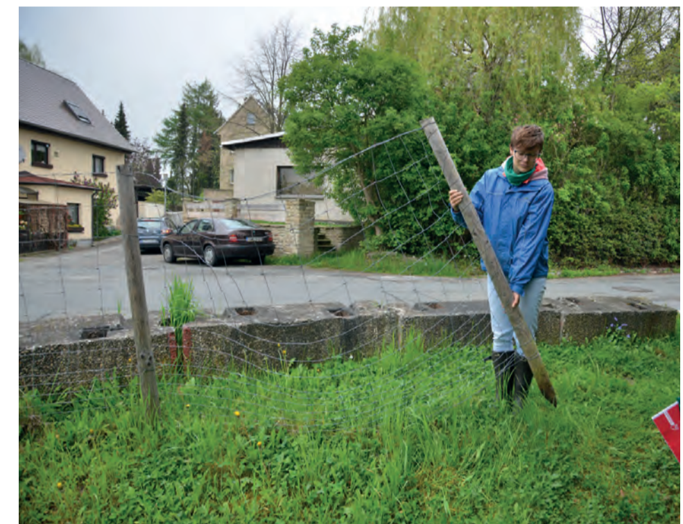
Bild 15: Offenbar nicht tief genug gegründet – eine Absperrung zur Fischottererkennung hat sich gelöst oder wurde beschädigt. Hier wurde die Reparatur beauftragt.
