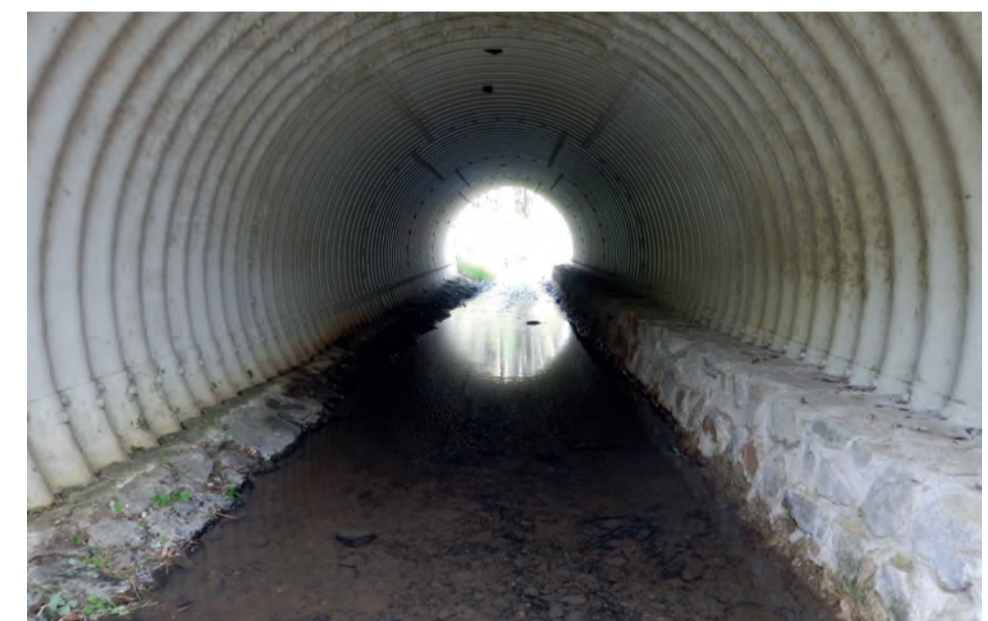
Bild 16: Brücke über den Triebbach bei Pleisgitz (Tri1). Bei der Evaluation wurden keine Fischotternachweise, aber Lösungen anderer Tiere auf der Berme gefunden. Das zeigt, dass die Querung verschiedenen Arten hilft.
