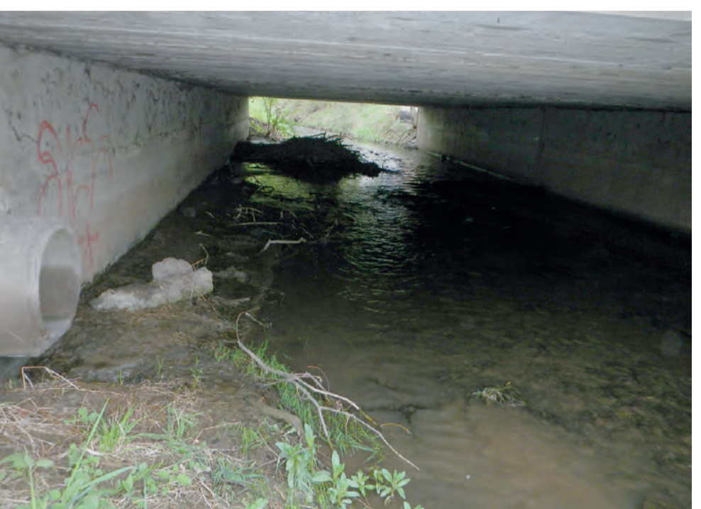
Bild 10: Geschiebe- und Totholzablagerungen unter einer Brücke ohne durchgehenden Uferstreifen in Gera. Solche Ablagerungen können jederzeit vorkommen und erhöhen den Unterhaltungsaufwand.
